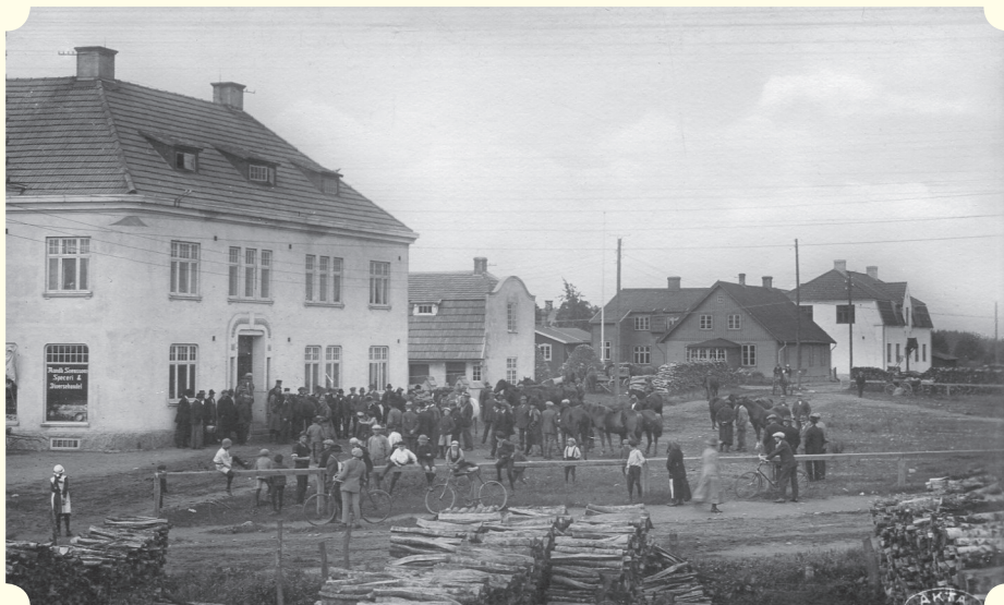
Torgdag i Sösdala för 100 år sedan. Detta är platsen vid "gamla" brandstationen. Huset bortom folket var det första Missionshuset vilket brann ner 1928. I främre huset fanns bl.a. livsmedel- och mjölkaffär.
